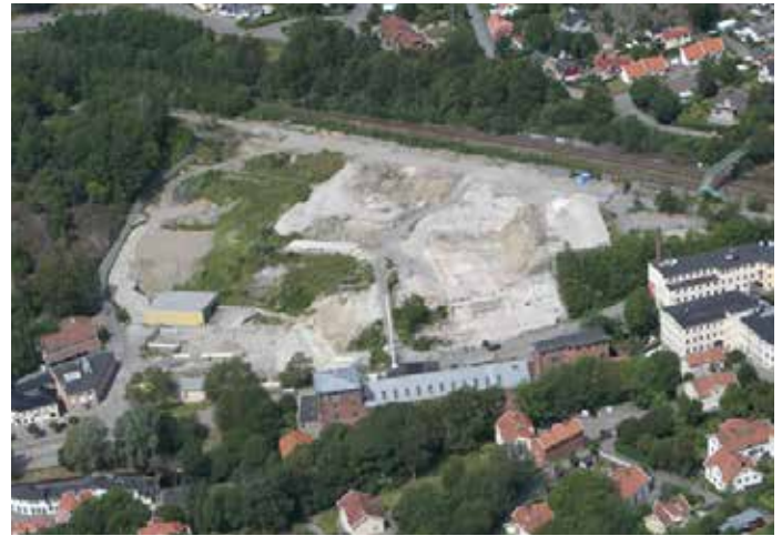
Rivningstomt i Kvarnbybacken, Mölndal, där kemikaliefabriken Hexicon låg. Det krävdes sanering av förorenad mark inom området.
