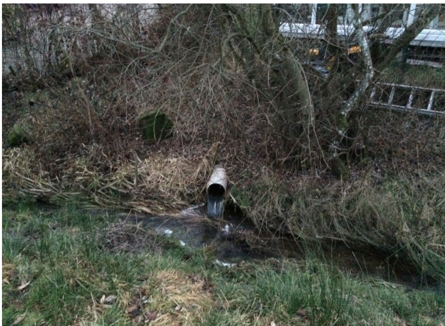
Figur 10 Utlopp för sydvästra koloniområdets dagvattensystem. I detta system avleds även de delar av Benarbäcken som nått bäcken söder om planområdet.
