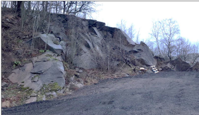
Figur 14 – Östra slänten. Källa: Norconsult, 2021-01-15
