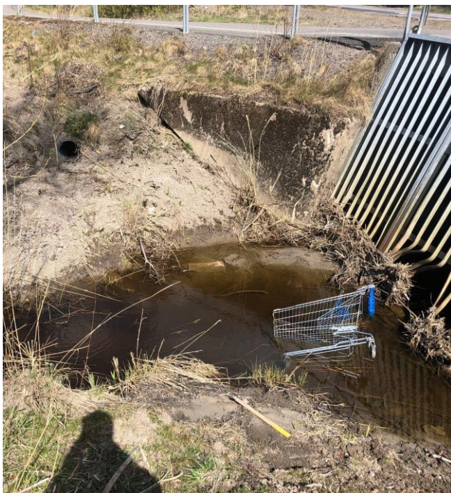
Figur 7. Inloppet till den långa kulverteringen vid Kållereds köpstad utgör ett partiellt hinder i huvudfåran.
