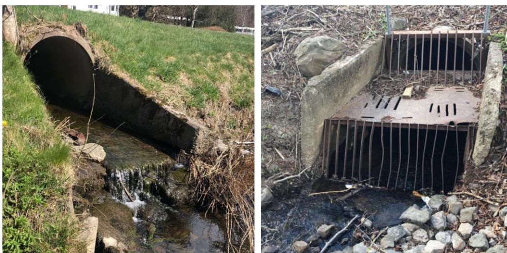
Figur 9a och 9b. Till vänster: Alebäckens utlopp i Kålleredsbäcken. Till höger: en gallerförsed trumma cirka 140 m uppströms.
