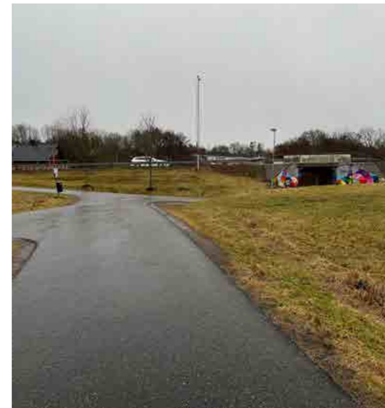
Gång- och cykelvägnät: GC-vägar vid områdets sydöstra hörn. GC-tunnel under Spårhagavägen mot Fågelsten i söder.
