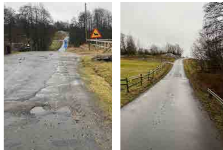
Väg- och GC-vägnät: Ingemantorpvägen som leder från Spårhagavägen och söderut längs områdets östra gräns. Standardhöjande åtgärder krävs vid eventuell exploatering. GC-väg som viker av österut mot Fågelsten, Lindome Station och centrum skymtas.
