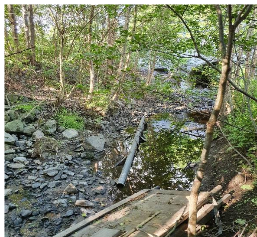
Figur 17. Skräp och sprängsten i bäckfåran öster om bron. Foto mot väster.
