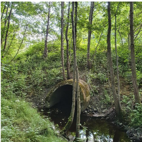
Figur 20. Bäckens östligaste del där bäcken kulvertas under GC-bro. Foto taget mot öster.
