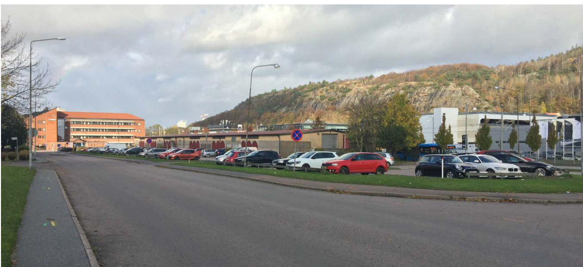
Befintlig markparkering med tvåplans parkeringsgarage inom Murmeldjuret 2 med vårdbyggnad i bakgrunden.
