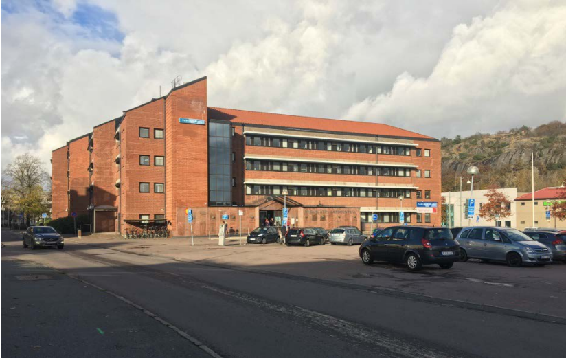
Befintlig vårdbyggnad med vårdcentral m.m. inom Murmeldjuret 4 med tillhörande markparkering
