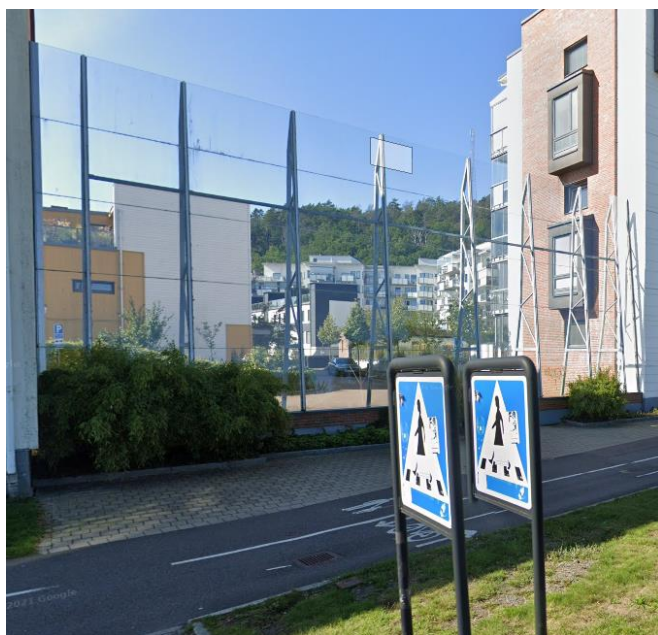
FIGUR 19. EXEMPEL PÅ SKÄRMUTFORMNING MED TILLRÄCKLIG STYVHET/GRUNDLÄGGNING
