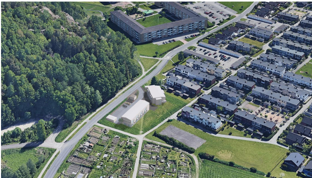
Vy från luften, åt nordost.
